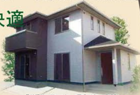
C号地現地モデルハウス/平成28年12月撮影
